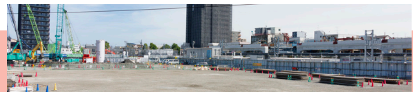
立石駅北口再開発工事一区が床を購入予定の東棟の建設は始まっていません。
