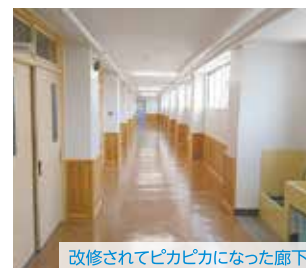
改修されてピカピカになった廊下
