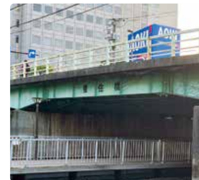
改修工事が始まる豊住橋
