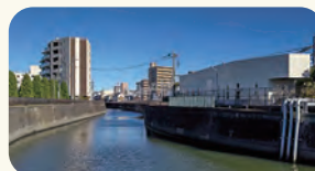
右手前は高濃度酸素水浄化施設
