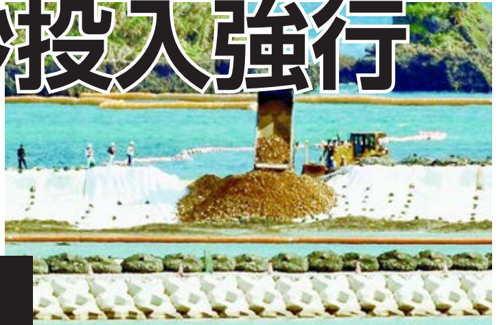
▲土砂の投入作業が強行された辺野古の現場
