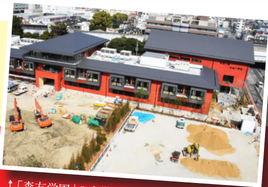
↑「森友学園」の小学校建設現場
